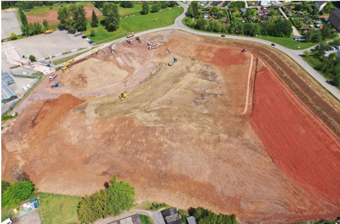
Abbildung 03 – Luftbild Sanierung der Halde 65 in Bad Schlema (Quelle: Wismut GmbH)
