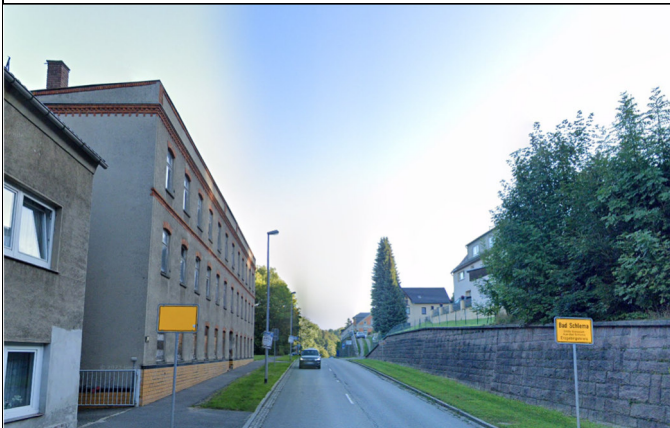
südwestliche Bebauung aus Richtung Ortseingang
