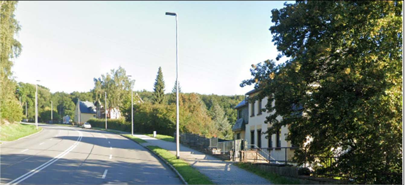
nördliche Bebauung aus Richtung Südosten
