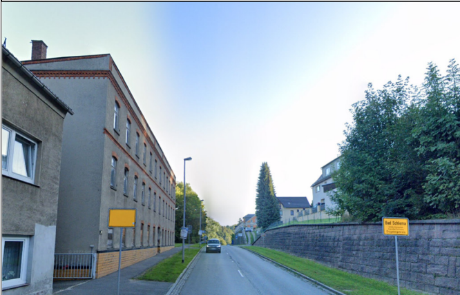
südwestliche Bebauung aus Richtung Ortseingang
