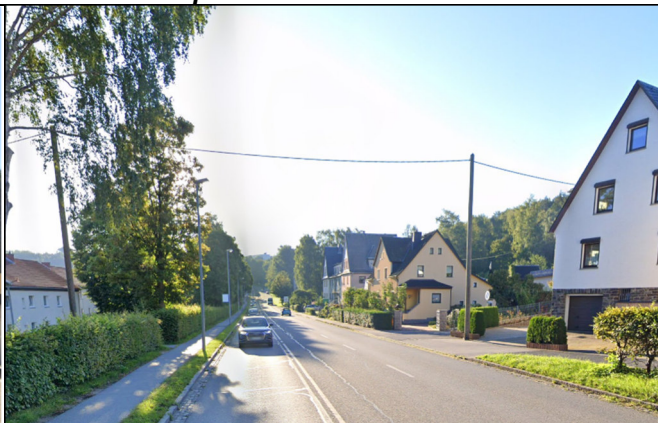
Bebauung ab Einmündung Gleesbergstraße in Richtung Osten
