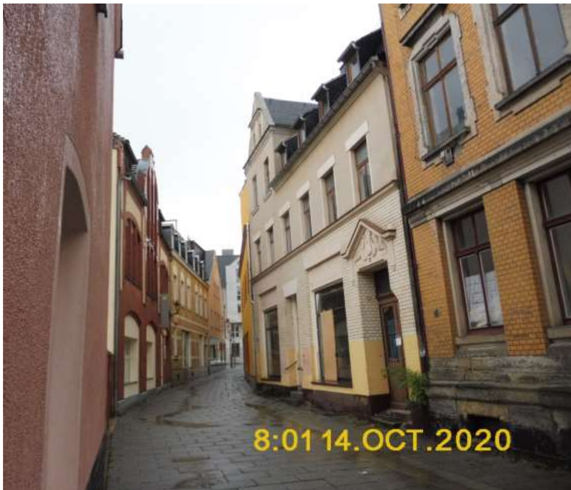
Foto Wohn- und Geschäftshaus Marktgäßchen 1 – Ansicht von Nord-Ost (vor Abbruch)
